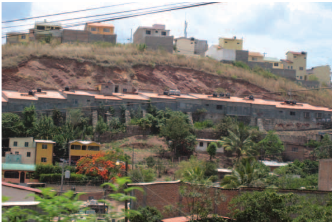
Novas moradias em região erodida de Tegucigalpa, em Honduras, refletem o crescimento descontrolado de assentamentos e a falta de planejamento.
