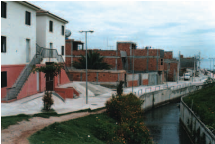
Imagens de antes e depois mostram o assentamento Parque Royal no Rio de Janeiro que foi melhorado por meio do programa Favela-Bairro.
