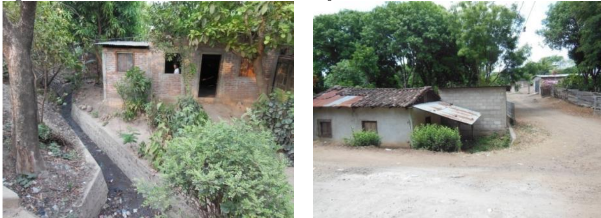
Figuras 2.7 Dos casas cerca de canales de drenaje
