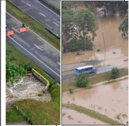
Figura 3.9 – Inundación de la Carretera de la Cordialidad, 2010
