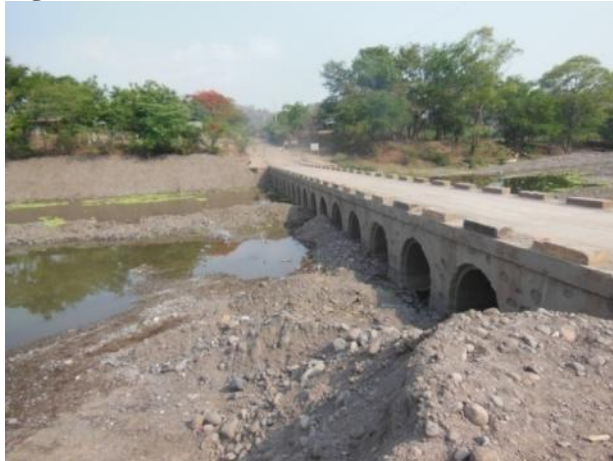
Figura 2.12c Erosión al costado del puente
